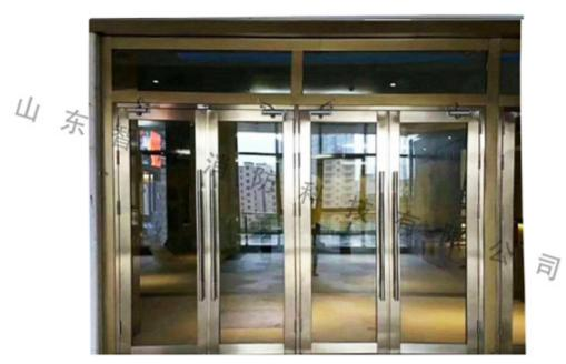
用钢质材料制作门框、门扇骨架和门扇面板,门扇内若填充材料,则填充对人体无毒无害的防火隔热材料,并配以防火五金配件所组成的具有一定耐火性能的门。钢质防火门门框内应充填水泥砂浆。门框与墙体应用预埋钢件或膨胀螺栓等连接牢固,其固定点间距不宜大于600mm□用钢质和难燃木质材料或难燃木材制品制作门框、门扇骨架、门扇面板,门扇内若填充材料,则填充对人体无毒无害的防火隔热材料,并配以防火五金配件所组成的具有一定耐火性能的门。桓台钢木质防火门安装智雷消防科技已实现生产规模化、管理现代化、服务配套化。
